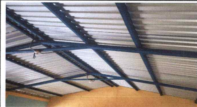
Foto 4: mantenimiento a estructura metálica costanera
