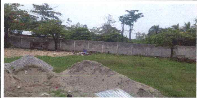
Foto 3: reparación de muro perimetral
