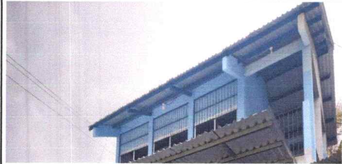
Foto 1: sustitución de lamina en mal estado
