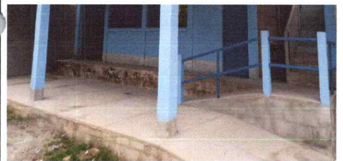
Foto 5: sustitución de piso de concreto
