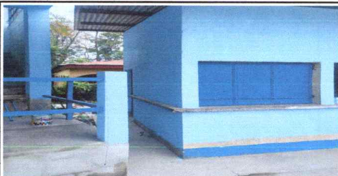
Foto 6: reparación de ventanas
