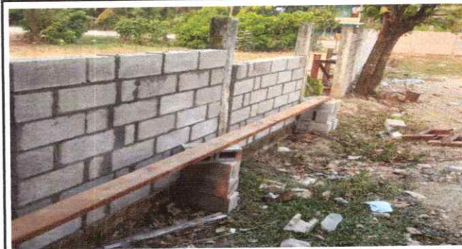
Foto 3: reparación de muro perimetral
