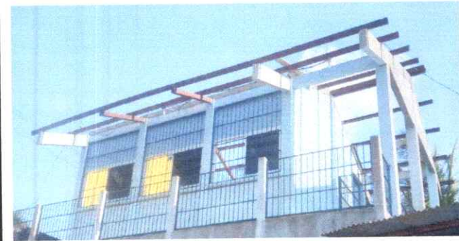
Foto 1: sustitución de lamina en mal estado
