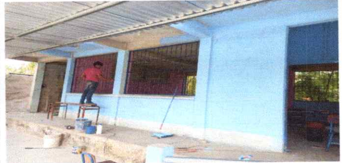
Foto 2: pintura exterior e interior
