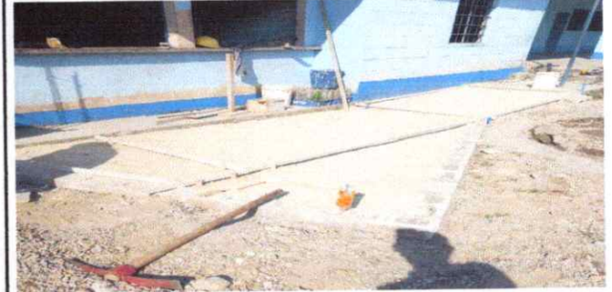
Foto 6: reparación de ventanas
