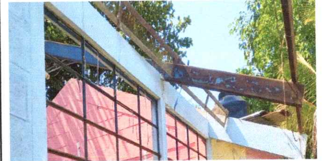
Foto 4: de costanera a estructura metálica
