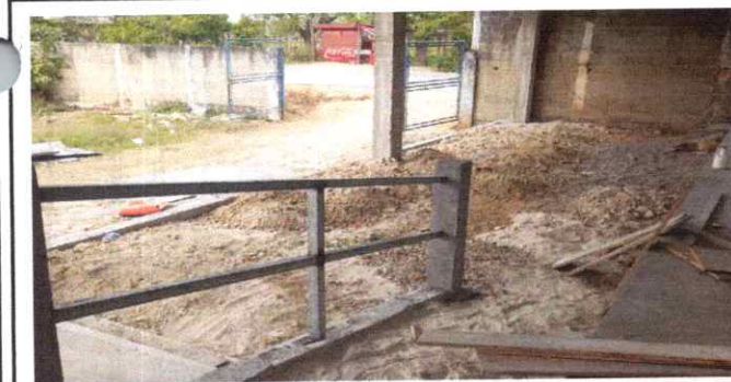
Foto 5: sustitución de piso mde concreto
