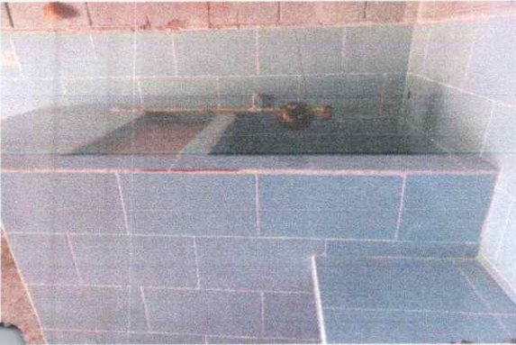
FOTO 13: SUSTITUCION DE PILA DE CEMENTO DE DOS LAVADORES
