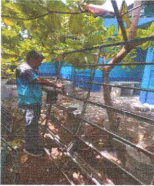
FOTO 7: MANTENIMIENTO DE BALCONES DE METAL
