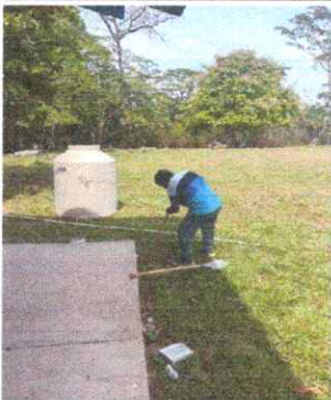
FOTO 11: SUSTITUCION DE DEPOSITO DE AGUA
