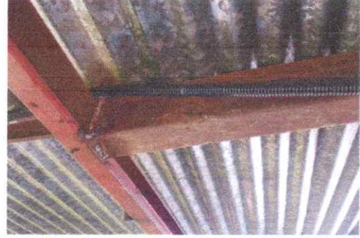
FOTO 2: SUSTITUCION DE ESTRUCTURA DE SOPORTE DE METAL
