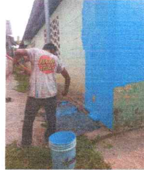
FOTO 8: PINTURA EN MURO EXTERIOR
