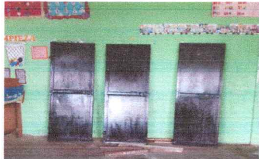
FOTO 4: MANTENIMIENTO A ESTRUCTURA METÁLICA
