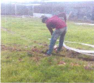
FOTO 9: SUSTITUCION DE TUBERIA DE AGUA POTABLE
