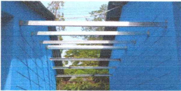
FOTO 3: SUSTITUCION DE ESTRUCTURA D SOPORTE DE METAL POR METAL
