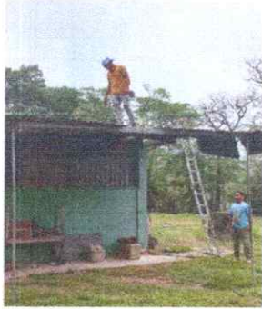
FOTO 1: SUSTITUCION DE LÁMINA
