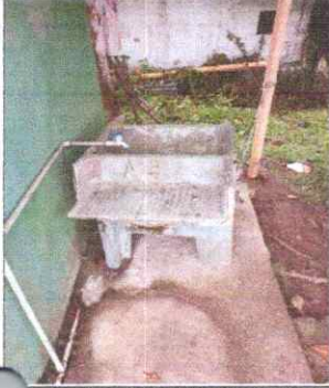
FOTO 13: SUSTITUCION DE PILA DE CEMENTO DE DOS LAVADORES
