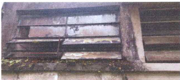
FOTO 7: MANTENIMIENTO DE BALCONES DE METAL
