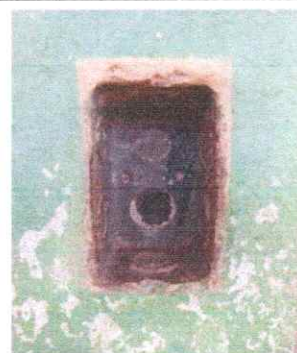
FOTO 10: SUSTITUCION DE DUCTO ELÉCTRICO + ACCESORIOS
