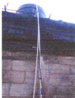
FOTO 11: SUSTITUCION DE DEPOSITO DE AGUA
