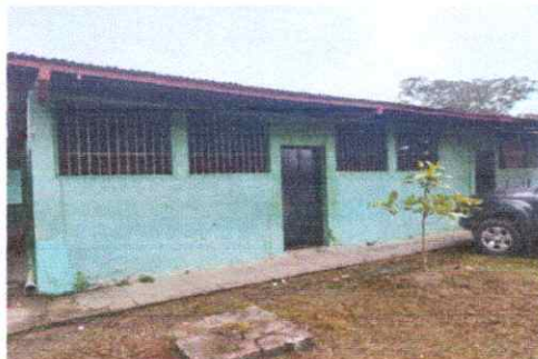
FOTO 8: PINTURA EN MURO EXTERIOR
