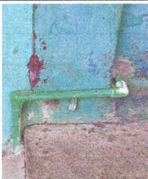
FOTO 9: SUSTITUCION DE TUBERIA DE AGUA POTABLE
