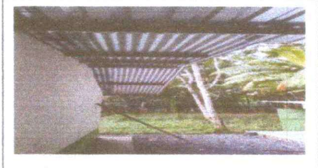
Foto 7: SUSTICIÓN DE SOPORTE DE MADERA POR METAL
