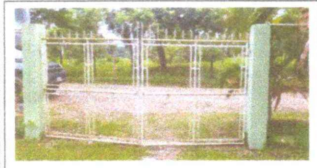
Foto 8: SUSTICIÓN DE PORTON DE METAL
