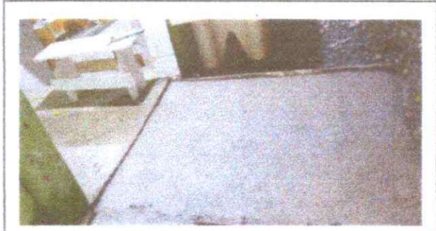
Foto 9: REPARACIÓN DE PISO CERAMICO
