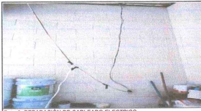
Foto 5: REPARACIÓN DE CABLEADO ELECTRICO
