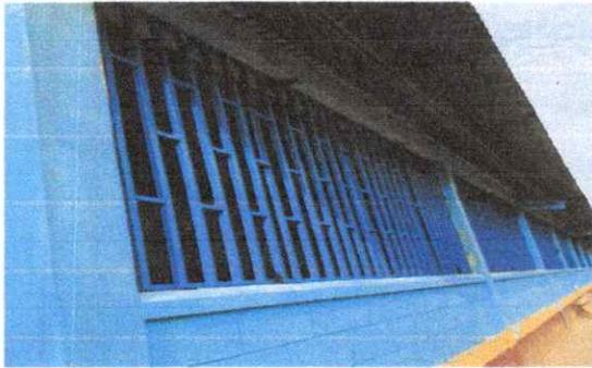
Foto 9: SUSTITUCION DE VENTANALES DE VIDRIO POR BALCONES DE METAL
