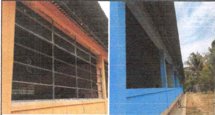
Foto 9: SUSTITUCION DE VENTANALES DE VIDRIO POR BALCONES DE METAL
