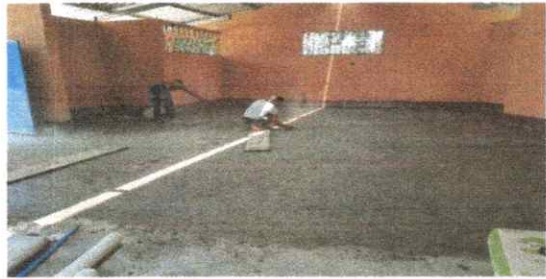
Foto 3: SUSTITUCION DE PISO
