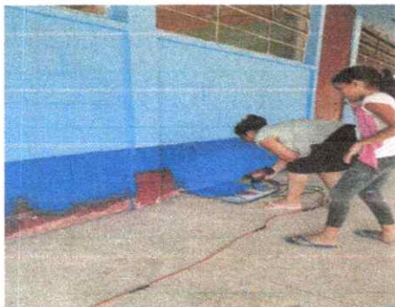
Foto 5: PINTURA INTERIORES Y EXTERIORES
