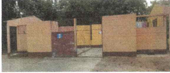
Foto 1: CAMBIO DE TECHO
