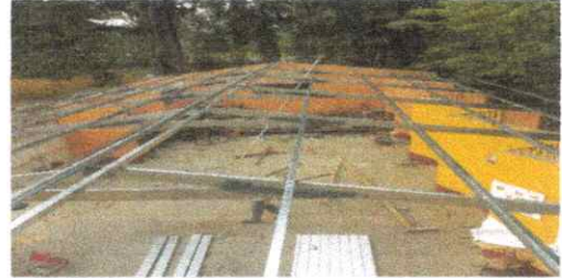
Foto 2: ESTRUCTURA DE TECHO
