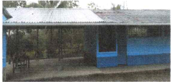
Foto 4: CAMBIO DE CANALES PLUVIAL
