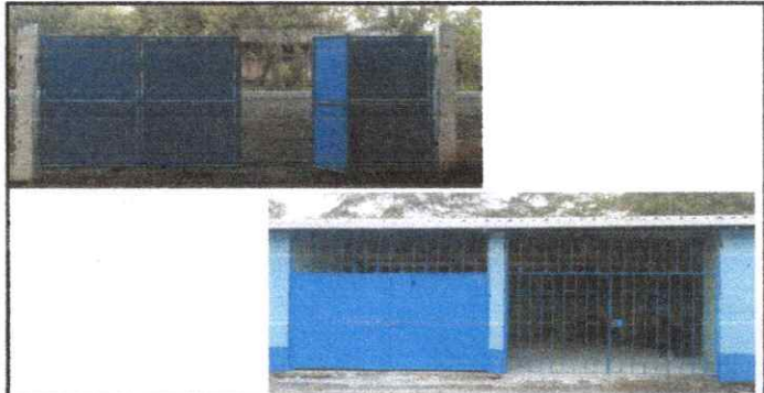
Foto 6: MANTENIMIENTO A PORTONES
