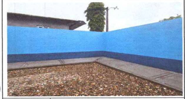
Foto 7: REPARACIÓN DE MURO PERIMETRAL DE BLOCK
