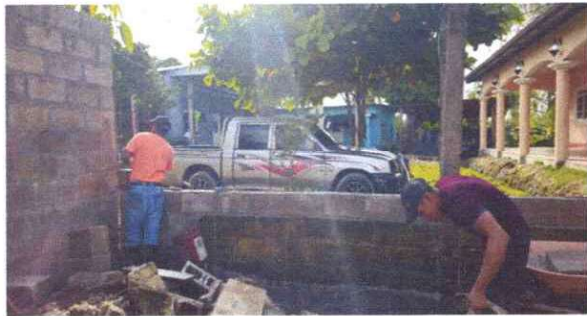
Foto 4: REPARACIÓN DE MURO PERIMETRAL DE BLOCK
