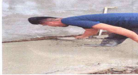
Foto 5: REPARACIÓN DE BANQUETAS DE CONCRETO
