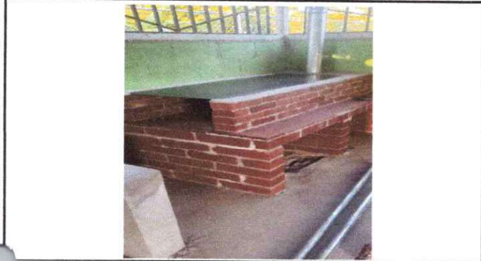
Foto 1: Mantenimiento de Cocina
