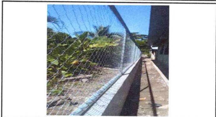
Foto 2: Mantenimiento de Muro Perimetral
