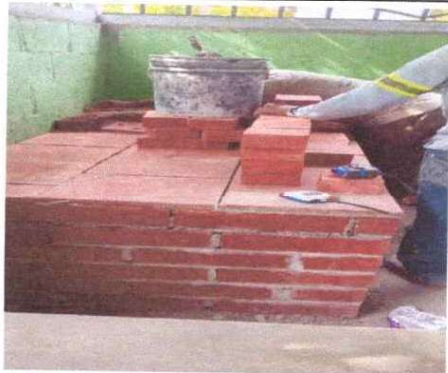
Foto1: Mantenimiento de Cocina
