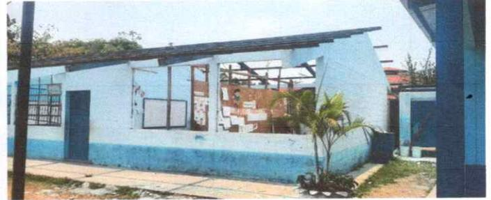
Estructura de metal listga para ser pintada y luego se sustituirá la lámina por lámina troquelada calibre 26' y los capotes
