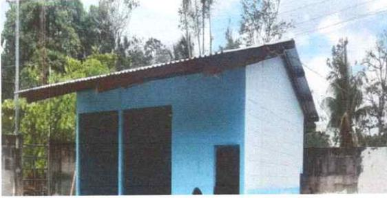
Dando inicio a quitar la lámina para ser sustituida por lámina Troquelada calibre 26'
