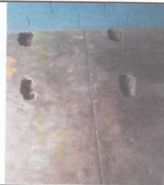
Reparación de piso de torta de concreto
