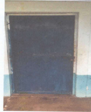
Reparación de puertas de metal de las aulas
