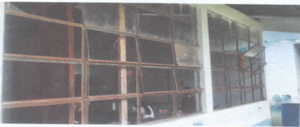
Sustitución de balcones de metal de ventanas
