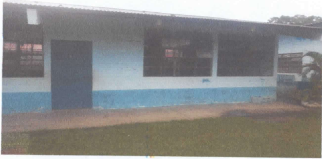
Sustitución de Lámina, por lámina troquelada y capotes
