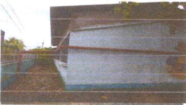
Foto 3. Parte de atrás de las aulas.
