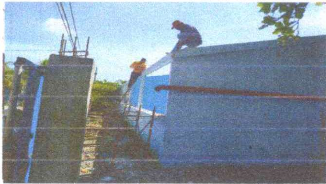
Foto 3. Parte de atrás de las aulas
