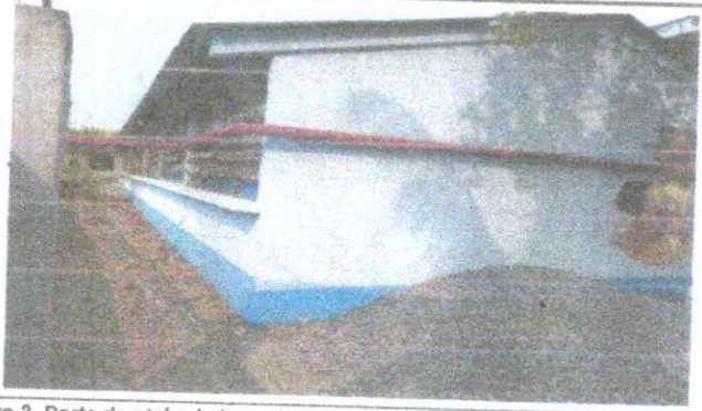
Foto 3. Parte de atrás de las aulas.
