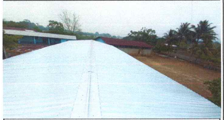
Foto 2: INSTALACION DE LAMINA TROQUELADA CALIBRE 26
