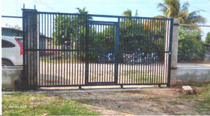
Foto1: MANTENIMIENTO DE PORTONES DE METAL
