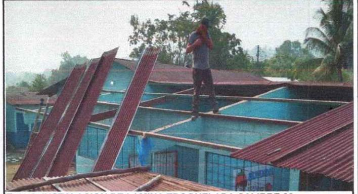
Foto 2: INSTALACION DE LAMINA TROQUELADA CALIBRE 26
