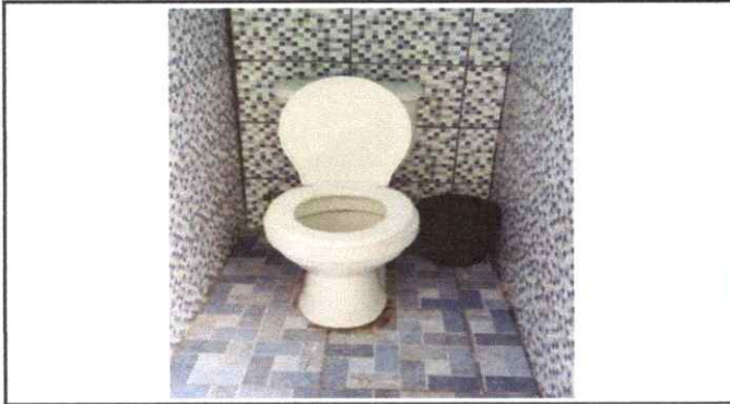
Sustitución de inodoro
