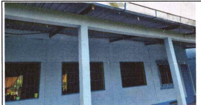
Pintura en muros exteriores e interiores
