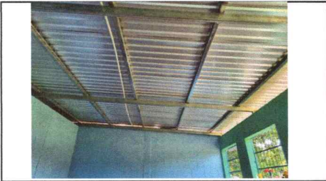
Sustitución de lámina, por lámina troquelada
