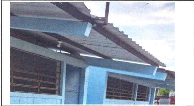
Sustitución de lámina, por lámina troquelada
