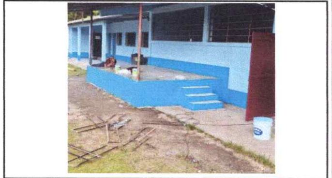
Mantenimiento a estructura de metal de ventana
