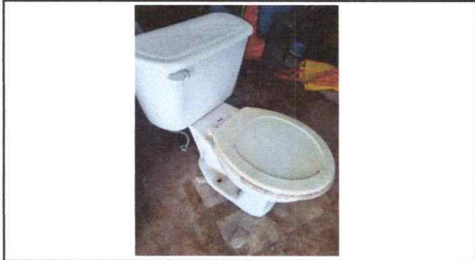
Sustitución de inodoro
