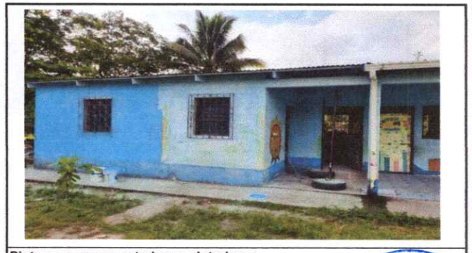
Pintura en muros exteriores e interiores
