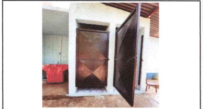
Mantenimiento a estructura
