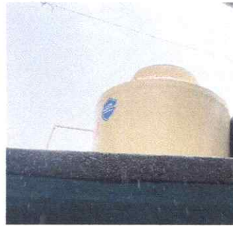
8. Repación y mantemiento de sisternas/depositos de agua
