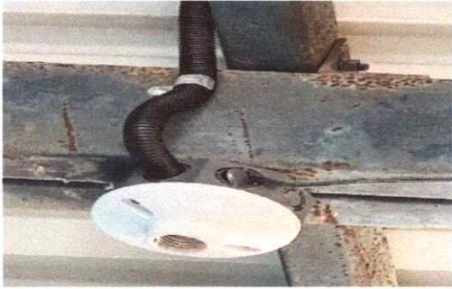
7. Reparación sistema electrico
