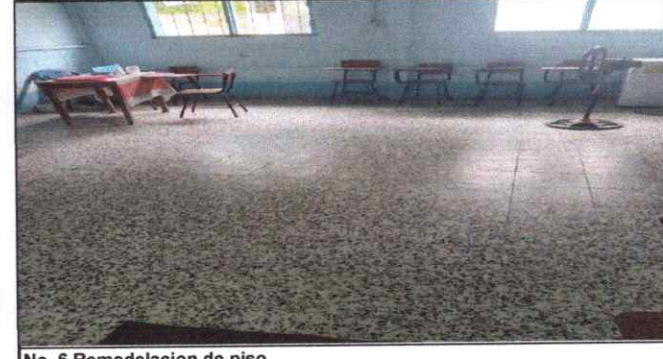
No. 6 Remodelacion de piso
