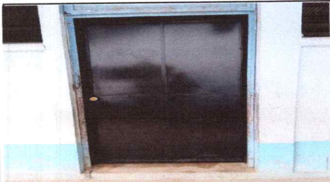
No.3 Cambio de puertas de madera a metal
