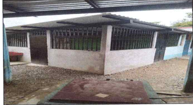
No.4 Remodelacion de cocina
