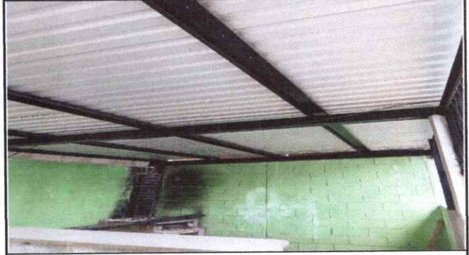
No.2 Sustitucion de Lamina de cocina
