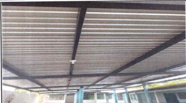
No.1 Sustitucion de Lamina de galera
