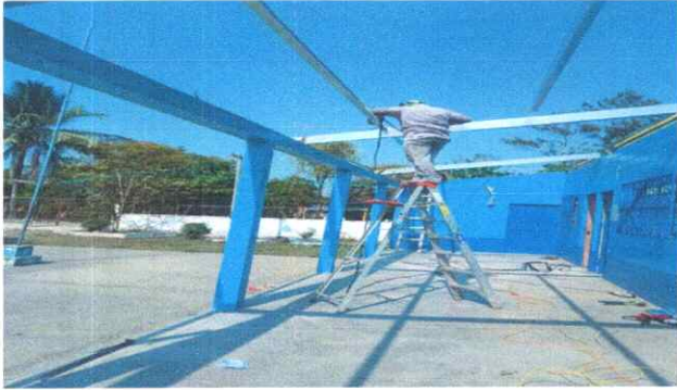
Foto1: COLOCACION ESTRUCTURA DE METAL
