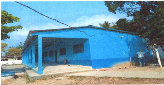
Foto 5: TERMINADO EL ENTECHADO
