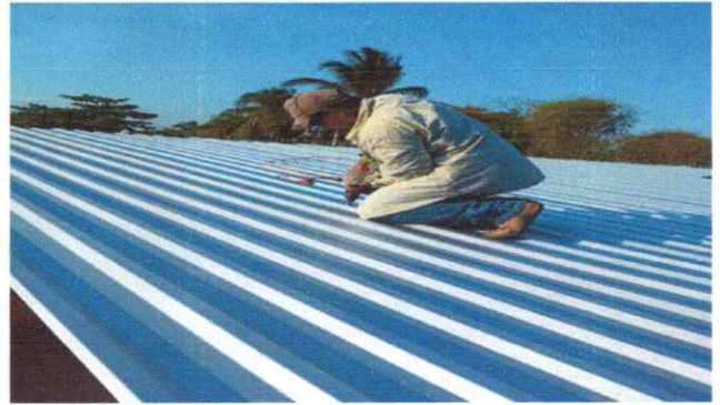
Foto 2: COLOCACION DE LAMINA
