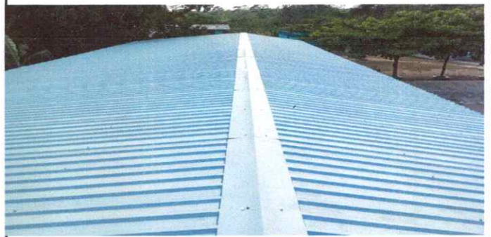
Foto 4: ESTRUCTURA Y ENLAMINADO TERMINADO
