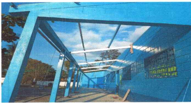
Foto 3: COLOCACION ESTRUCTURA DE METAL
