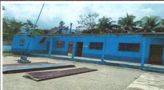
Foto 2: SUSTITUCION DE LA LAMINA EN MAL ESTADO
