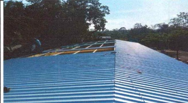
Foto 6: SUSTITUCION DE MADERA POR METAL Y COLOCACION DE LAMINA
