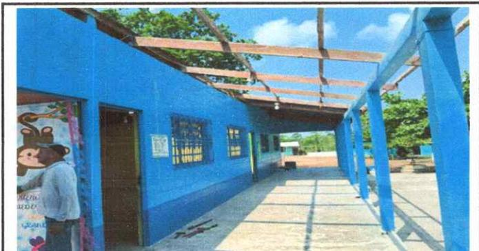
Foto 3: SUSTITUCION DE LA ESTRUCTURA DE MADERA EN MAL ESTADO
