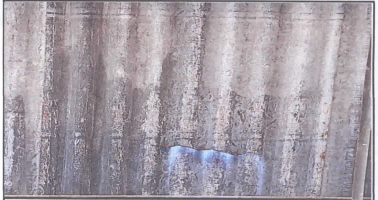
Foto 2: Sustitucion de Lamina
