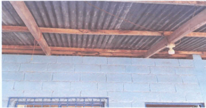
Foto 1: Sustitucion de Estructura de Madera por metal de techo
