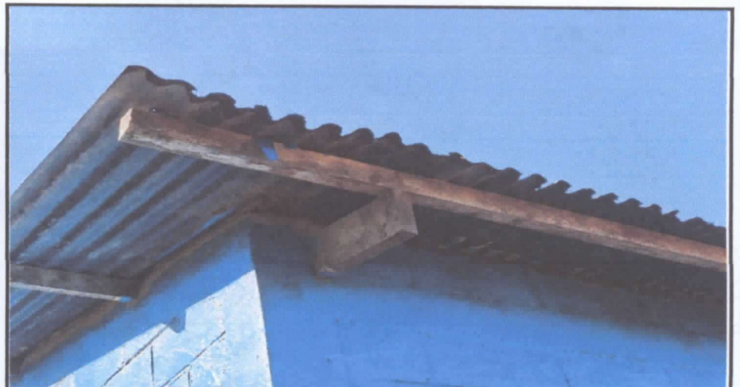
Foto 4: Sustitucion de estructura de madera por metal de techo
