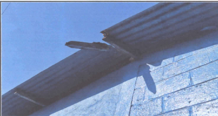
Foto 3: Sustitucion de Estructura de madera por metal de techo
