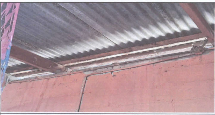
Foto 5: Sustitucion de estructura de madera por metal de techo
