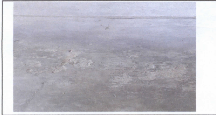
FOTO 1. Sustitucion de piso de torta de concreto por piso de granito.
