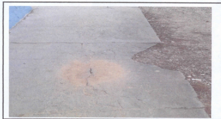
FOTO 4. Reparacion de tortas de concreto.
