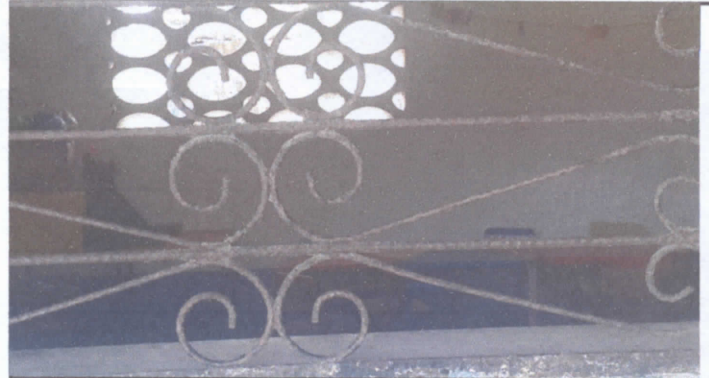
FOTO 2. Sustitucion de balcones
