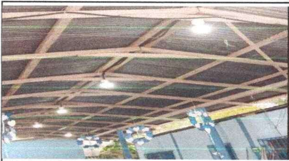
Foto1: Sustitución de focos ahorradores, plafoneras, interruptores simples, flipones y cableado eléctrico.
