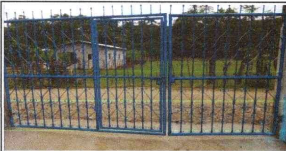
Foto 5: Mantenimiento a portones de metal.
