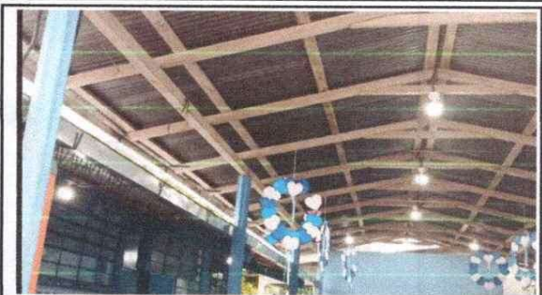
Foto 2: Sustitución de focos ahorradores, plafoneras, interruptores simples, flipones y cableado eléctrico.
