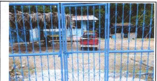
Foto 6: Mantenimiento a portones de metal.
