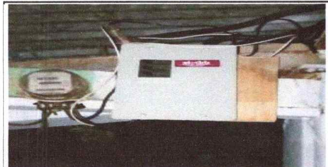
REPARACIÓN DE CABLEADO ELECTRICO
