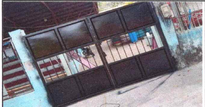
PORTONES DE SUSTITUCIÓN
