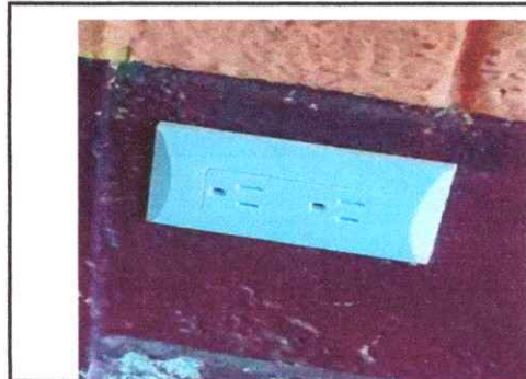
REPARACIÓN DE CABLEADO ELECTRICO
