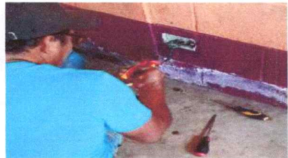
REPARACIÓN DE CABLEADO ELECTRICO
