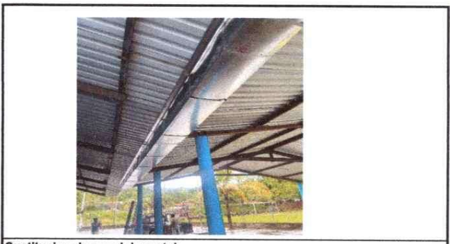
Sustitucion de canal de metal
