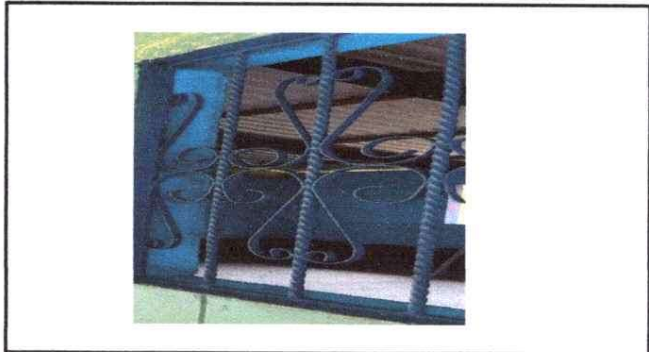
Reparación de estructura de metal de ventana
