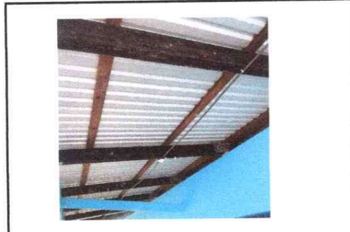
Reparacion de sistema Electrico
