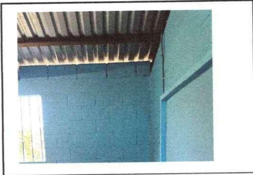
Pintura de muros Exteriores e interiores
