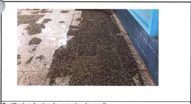
Sustitucion de piso de ceramica de granito
