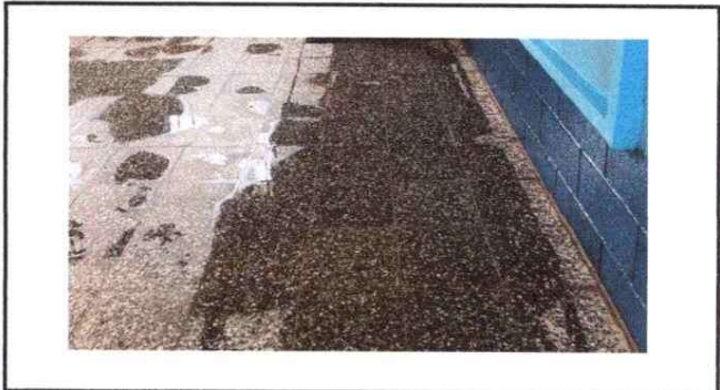
Sustitucion de piso ceramica de granito
