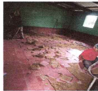
Sustitucion de piso de ceramica de granito
