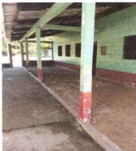
Sustitucion de piso de ceramica de granito
