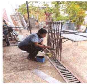
Reparacion de estructura de metal de ventana
