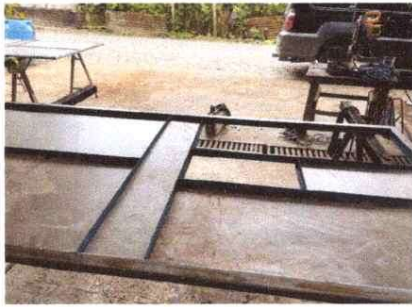
Sustitucion Puerta de Metal
