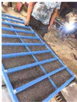
Sustitucion de estructura de metal de ventana
