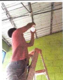
Reparacion de sistema electrico
