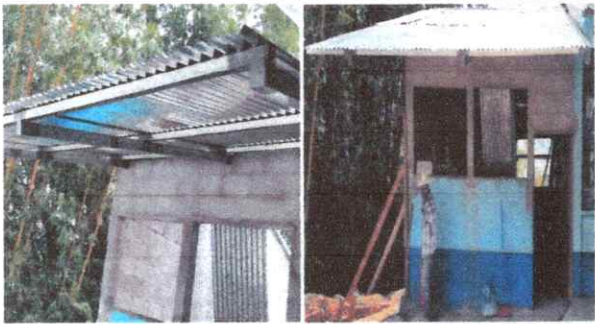
Sustitucion de estructura de soporte de madera, por metal
