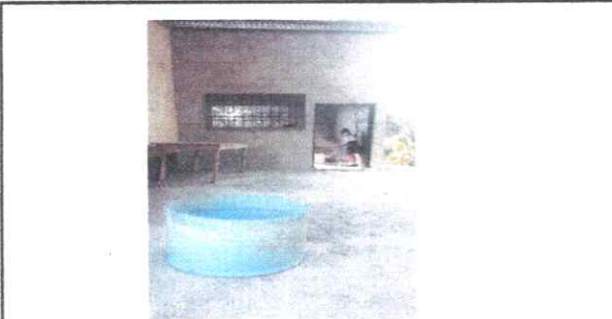
Reparacion de piso de torta de cemento
