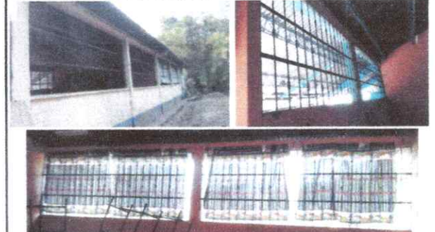
Sustitucion de balcones de metal
