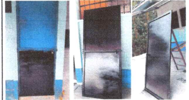
Mantenimiento de estructura
