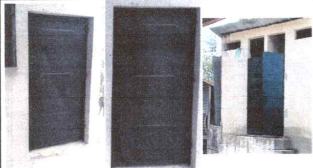
Sustitucion de Puerta
