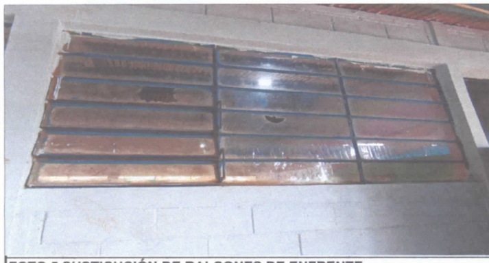
FOTO 5 SUSTICUCIÓN DE BALCONES DE ENFRENTA
