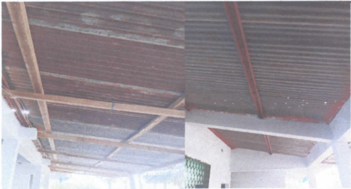
FOTO 1. SUSTITUCION DE LAMINA
