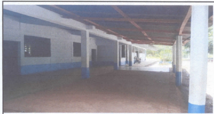
FOTO 4. PINTURA EN INTERIOR COMO EXTERIOR DE PAREDES DE ESCUELA
