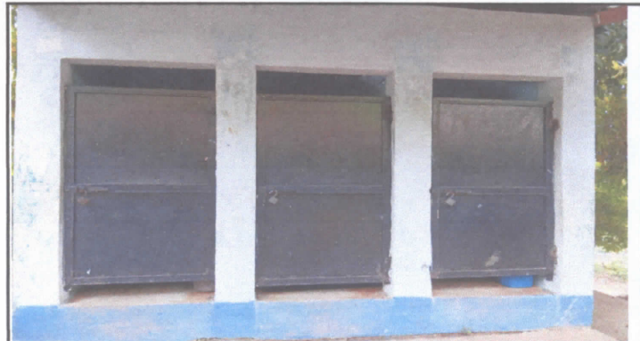
FOTO 2. SUSTITUCIÓN DE PUERTAS DE SANITARIOS
