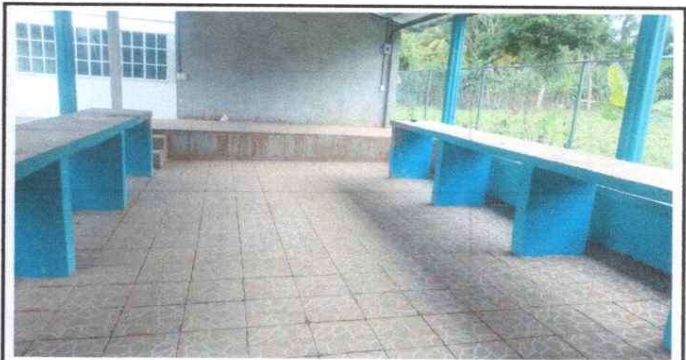
Foto 4: Sustitución de piso cerámico
