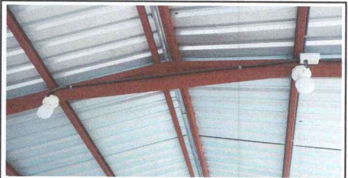
Foto 6: Sustitución de plafonera
