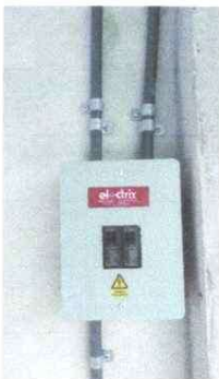
Foto 5: sustitución de tablero de flipones
