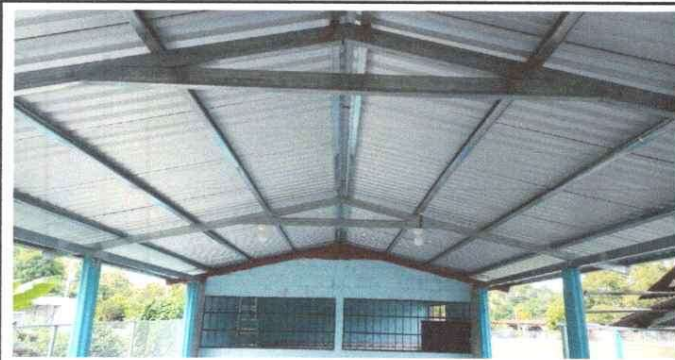
Foto 3: Sustitución de lámina troquelada alucin calibre 26
