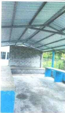
Foto 3: Sustitución de piso de torta de concreto
