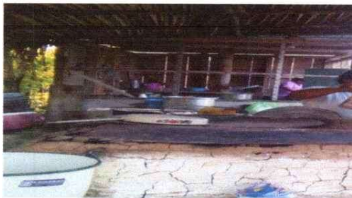
Foto 3: Sustitución de estufa rural completa incluye chimenea y plancha
