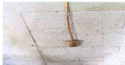
Foto 6: Sustitución de toma corrientes
