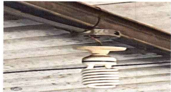
Foto 4: Sustitución de plafoneras
