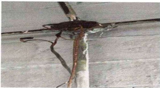
Foto 9: Sustrucción de ducto electrico
