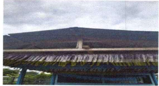
Foto 2: Sustitución de lamina por lamina troqueleada aluzinc calibre 26
