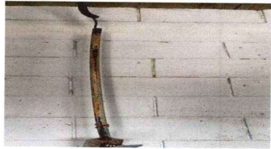
Foto 8: Reparación cableado electrico
