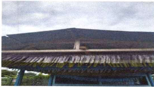
Foto1: Sustitución de estructura de madera por metal
