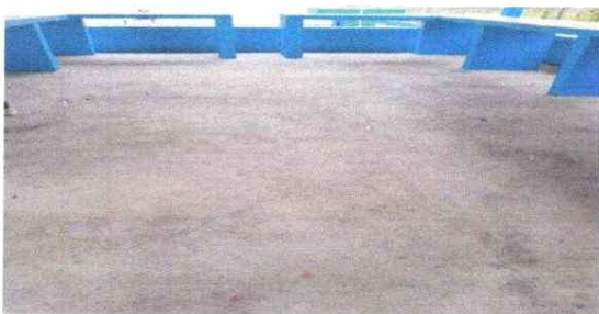
Foto 11: Sustrucción de piso ceramico
