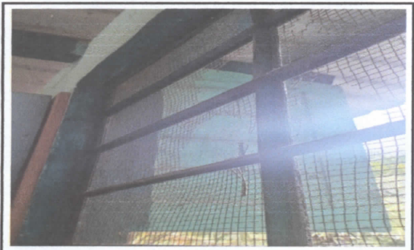
Reparación de toda la estructura metalica
