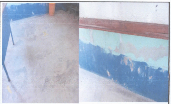
reparación de piso y repello de pared de un aula
