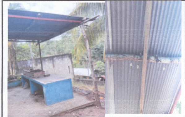
Reparación de Cocina, estructura del techo
