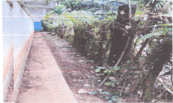
foto 4. construcción de muro perimetral de block.
