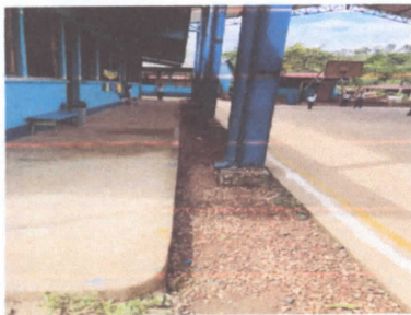
foto 5 sustitucion de piso de concreto por granito
