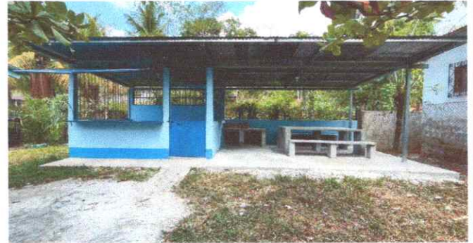
Foto 2: Reparación y ampliación de cocina, estructura metálica, ventanas y puerta, construcción de polletón, mesa y bancas de concreto, electricidad.
