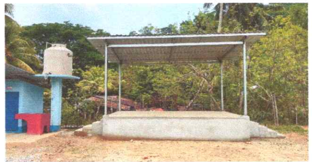
Foto 6: Construcción de escenario, estructura metálica y techo de lámina.
