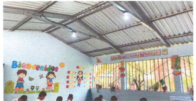
Foto 4: Instalación completa de energía eléctrica en dos salones de clases.
