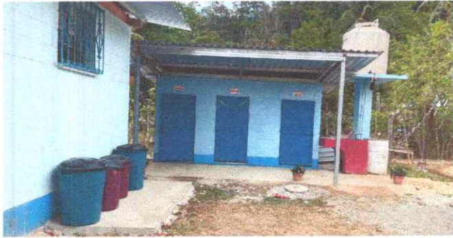
Foto 1: Reparación y ampliación de servicios sanitarios, sustitución de estructura metálica, drenajes, puertas, fosa séptica, pila y Rotoplas
