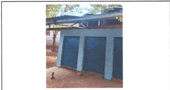
Foto 3: Reparación de servicios sanitarios, colocación de otro rotoplas, reparación de puertas, estructura metálica y techo de lámina
