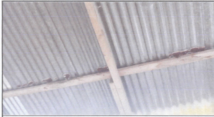
1. Cubierta de lámina y cambio de estructura de madera por metal.
