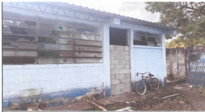
2.1 Reparación y mantenimiento de ventanas
