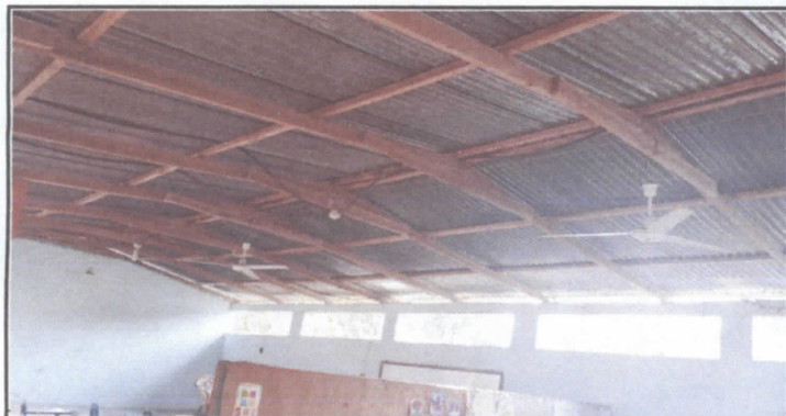
4. Reparación de sistema eléctrico
