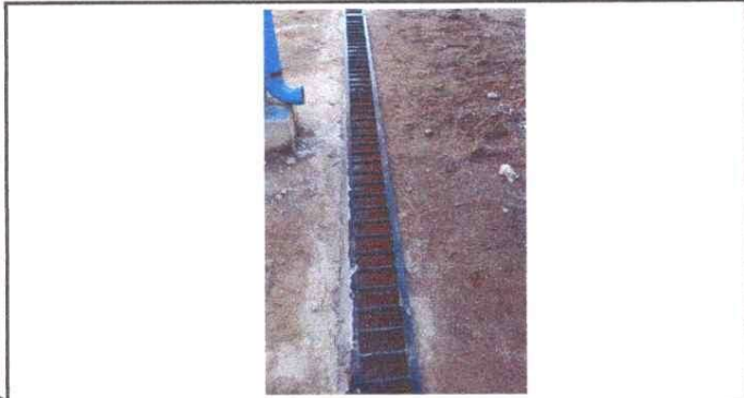
Foto 1: Reparación de drenajes.
