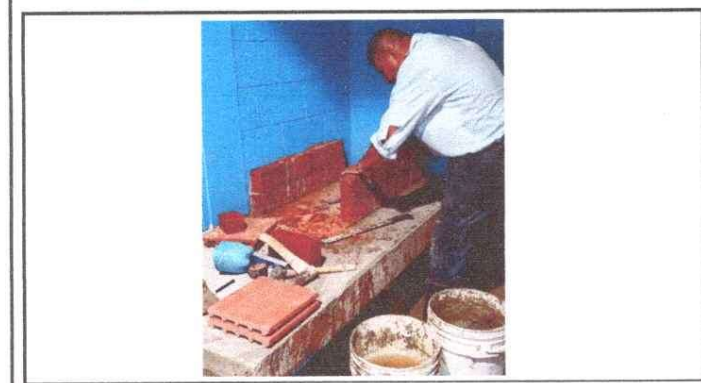
Foto 3: Sustitución de estufa rural.
