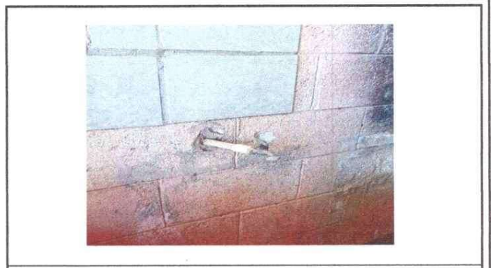
Foto 4: Sustitución de pila plastica.
