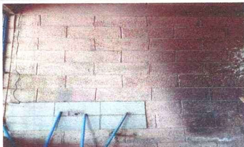
Foto 5: Reparación de repello y cernido de paredes.
