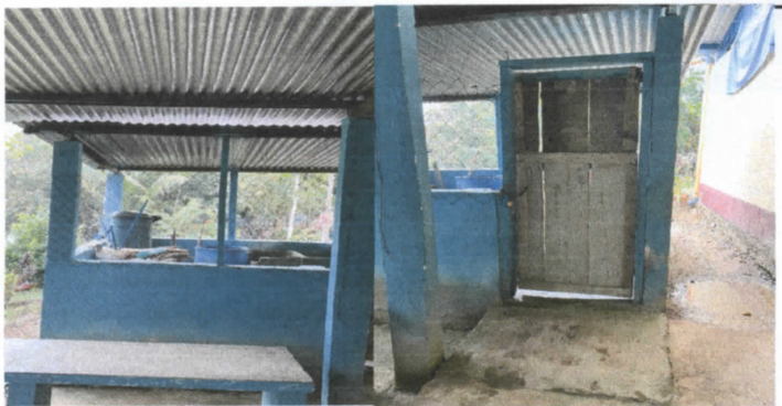
REPARACION DE COCINA PUERTA Y VENTANA
