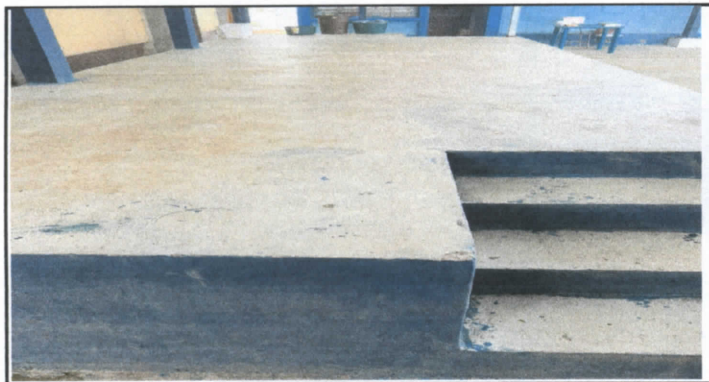
SUSTITUCIÓN DE PISO CERAMICO
