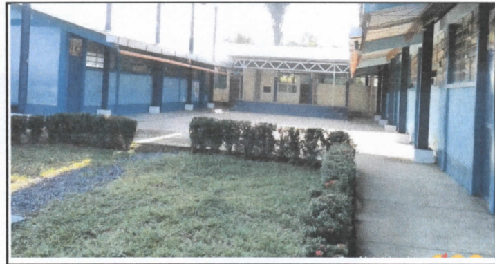
PINTURA EN MUROS EXTERIORES E INTERIORES
