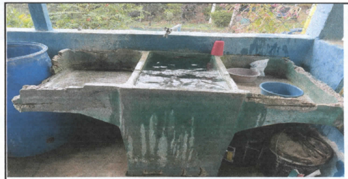
SUSTITUCION DE PILA DE CEMENTO DE DOS LAVADEROS
