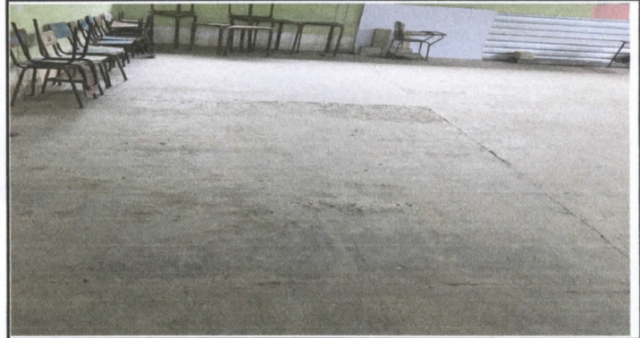
SISTITUCION DE PISO DE TORTA DE CONCRETO
