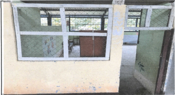
SUSTITUCIÓN DE PUERTAS DE METAL Y BALCONES DE METAL
