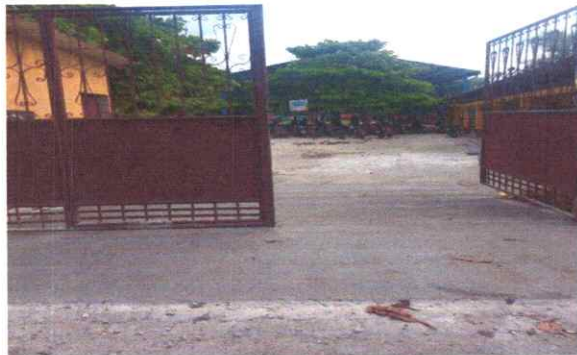
FOTO 5: Portón principal del establecimiento levantado.
