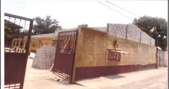
FOTO 2: 3 hiladas de block para el levantamiento de techo de aulas.
