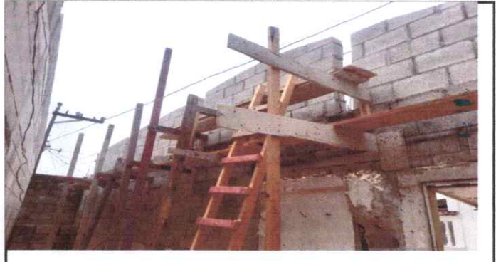
FOTO 4: Remozamiento de paredes de aula.
