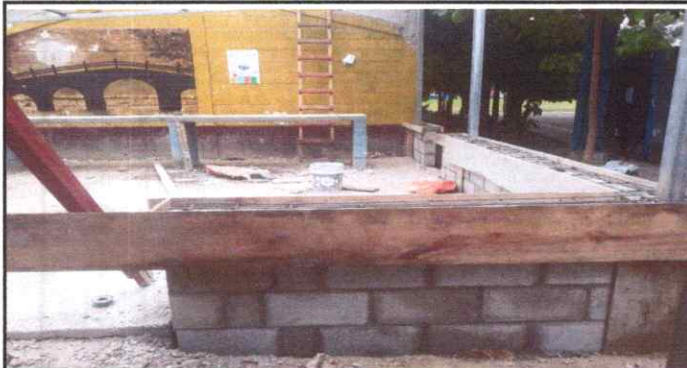
FOTO 3: Construcción de perímetro de galera.
