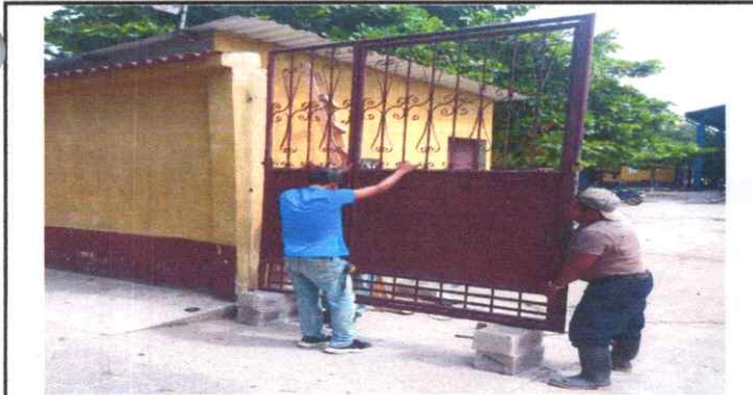
FOTO 5: Levantamiento de portón para poder realizar una rampa y que el agua llovediza no ingrese a la escuela en correntada.
