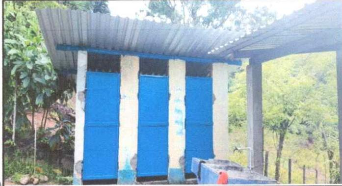
Foto13: MANTENIMIENTO A ESTRUCTURA (LIJADO, CAMBIO DE TUBO, CEPILLADO, SUJECIONES, APLICACIÓN DE PINTURA) A PUERTA DE SERVICIOS SANITARIOS
