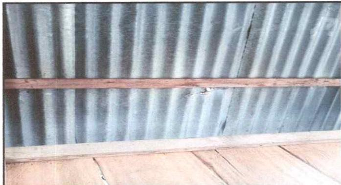
Foto 15: SUSTITUCIÓN DE LÁMINA, POR LÁMINA TROQUELADA ALUZINC CALIBRE 26 PIES
